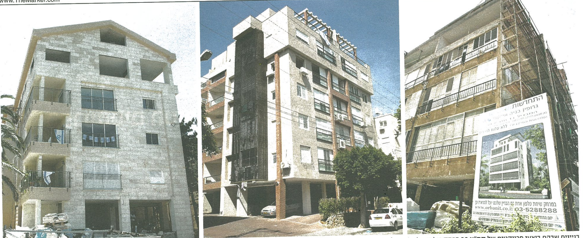
בניינים שבהם בוצעו פרויקטים של תמ"א 38 ברמת גן (מימין). ראשון לציון וחיפה. "אין תמריץ מספיק לחיזוק מבנים באזורי הפריפריה"
